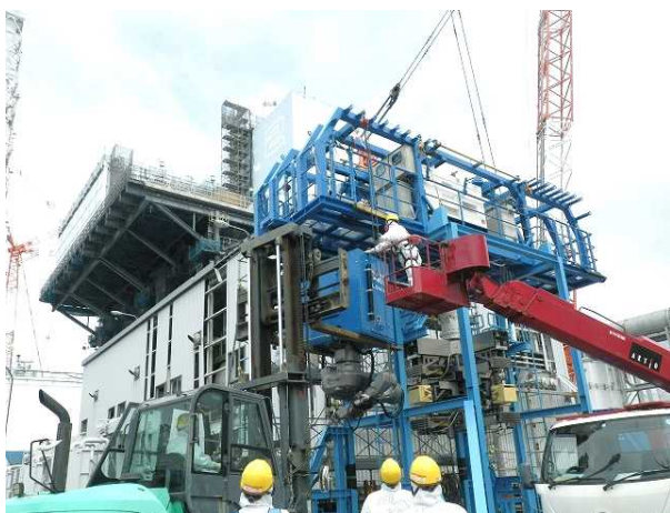
解体装置組立状況
