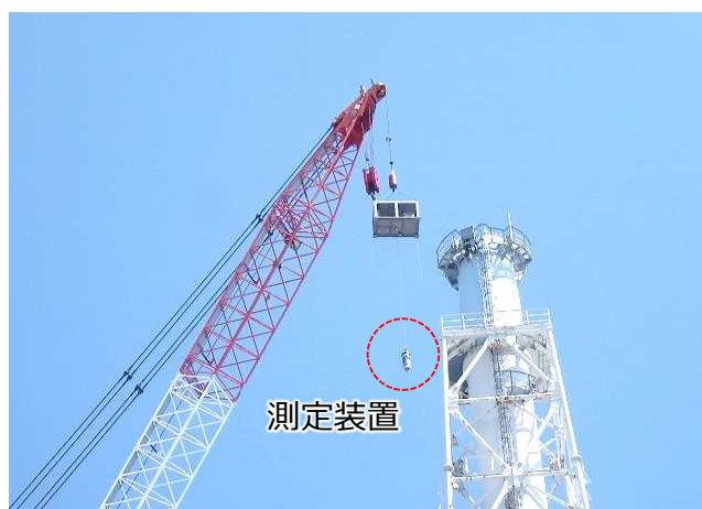
解体前調査の実施状況
