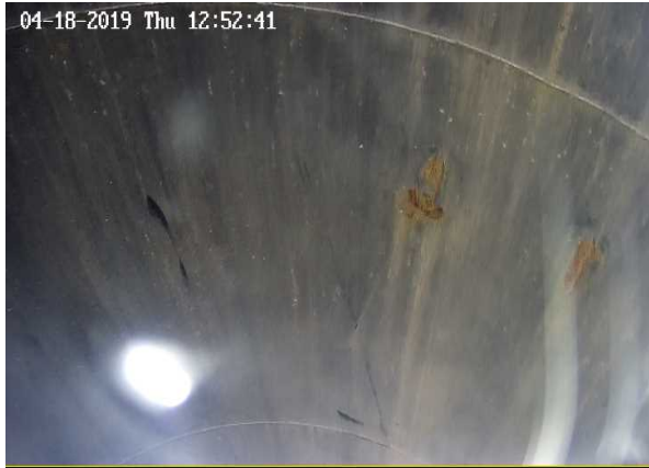
筒身内部調査の実施状況写真
