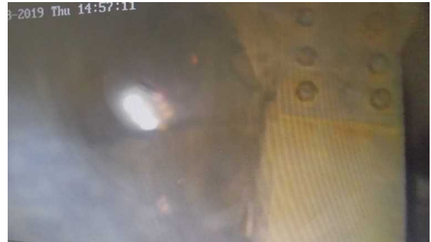
筒身内部支障物（H鋼）写真
